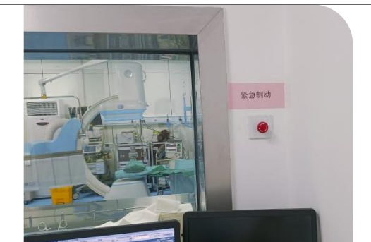
操作间紧急停机按钮
