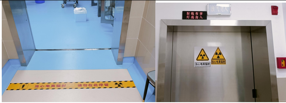
图 3-2 现场“两区”划分标落实情况
