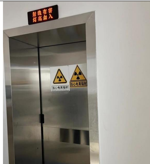
介入手术室3电离辐射标识
